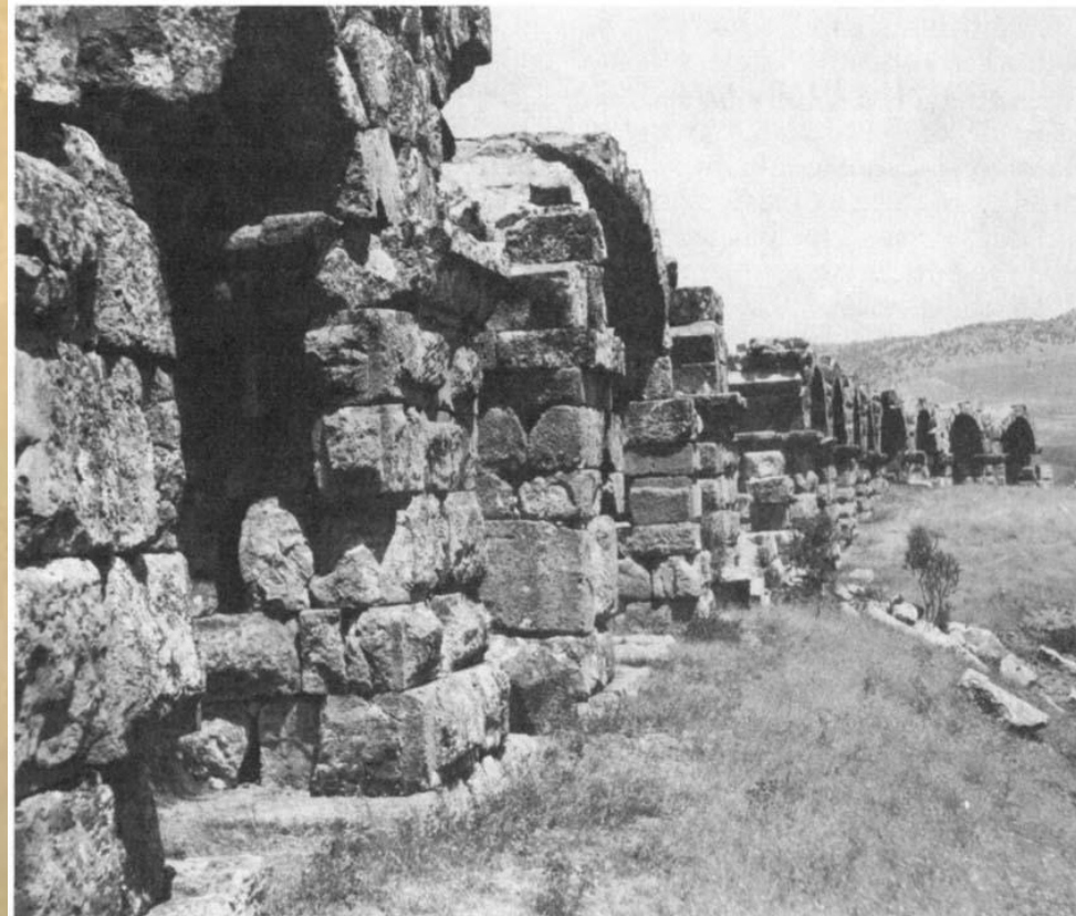
Acueducto cerca de Antioquía de Pisidia
